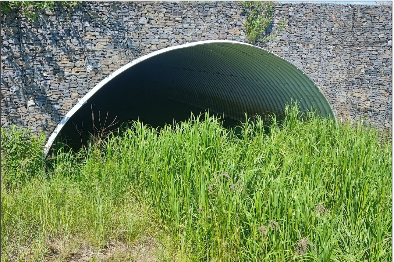
Tubosider pod D1 pro jižní meliorační kanál v dotčeném území, 28. 5. 2024 (RK)
