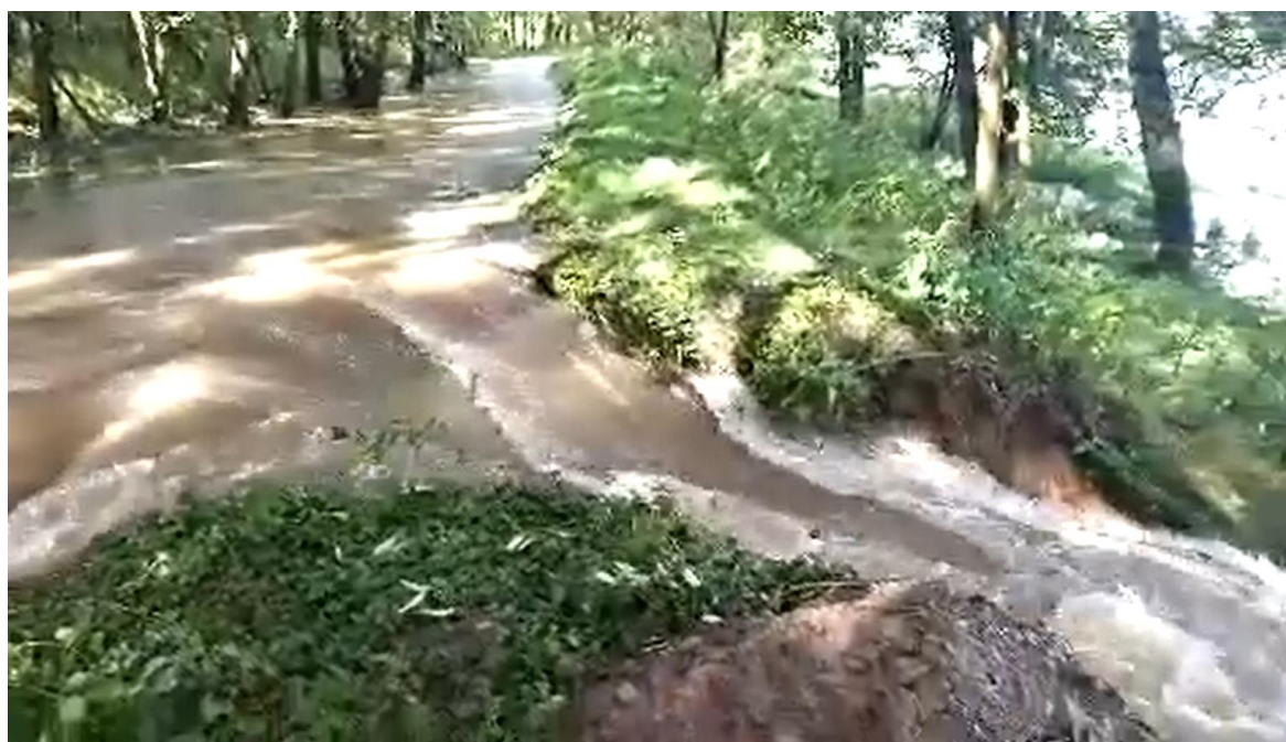
Obrázek 3-15 Povodeň 2024 – Prokopnutá hráz na Lutyňce
